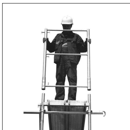
Rys. 1. Zakładanie ramki górnej
