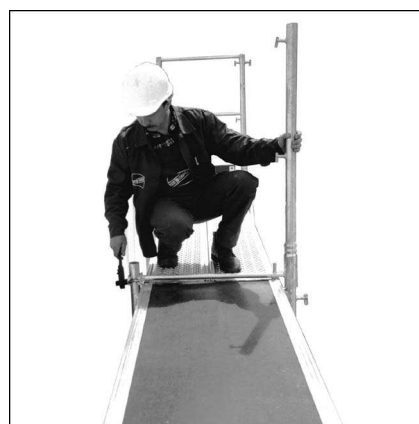
Rys. 2. Montaż ramki L
